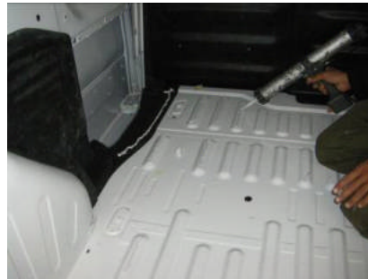
PHOTO 2: GOMMER AVEC SIKA LE PLANCHER DU VÉHICULE EN CORRESPONDANCE DES RELIEFS DE LA TÔLE.
